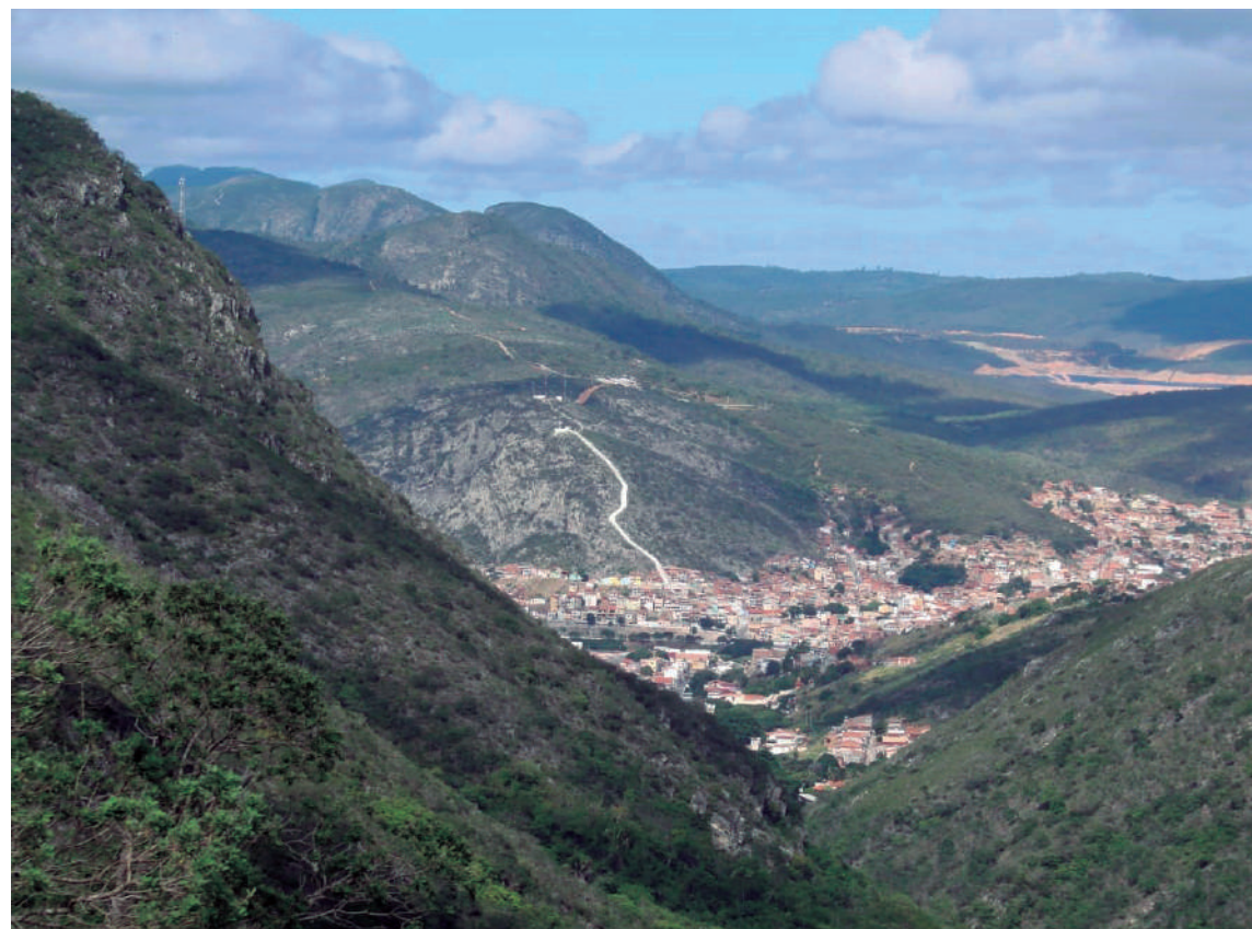
Figura 1: Cidade de Jacobina ameaçada por barragem de rejeitos à Montante (MENDES, 2021).
