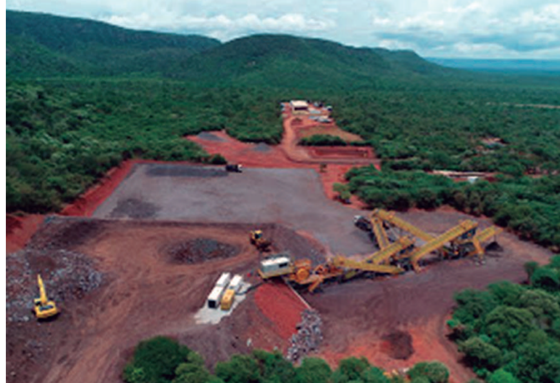
Figura 54: Planta da Tombador Iron Mineração na Serra da Bicuda (CPT, 2021).
