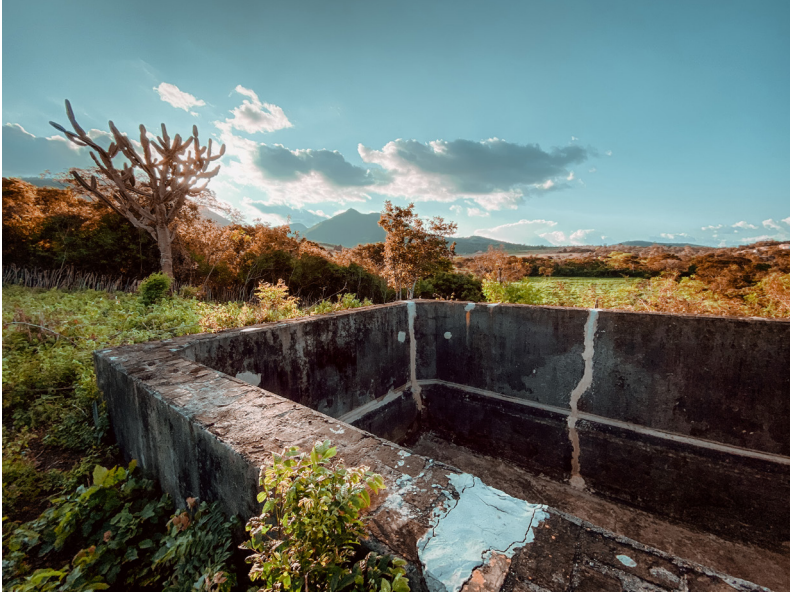
Figura 4: Ruínas da estrutura que abastecia a caixa d'água inglesa (HEBERTE, 2020).
