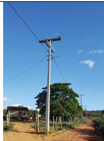
Foto 8: Ampliação da rede elétrica para os Covões.
