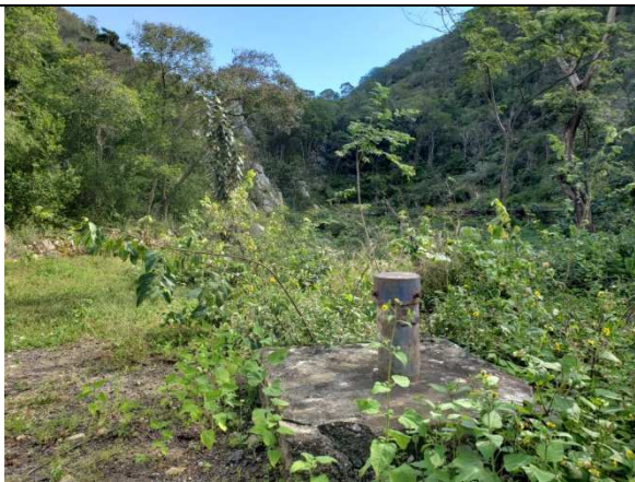
Foto 36. Poço tubular perfurado pela CERB ao lado da Barragem do riacho da Cachoeira. Poço não instalado. Com tampa.
