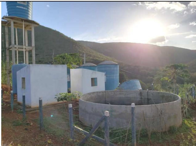
Foto 34. Sistema de abastecimento do Flamengo, Barrinha e adjacências, localizado na serra do Morgado. Abastece o sistema de Flamengo, Barrinha e adjacências.
