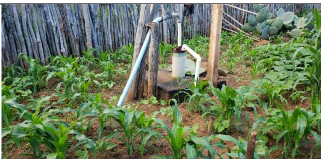
Foto 39. Poço tubular particular instalado. Pai de Fernando
