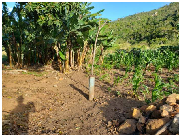
Foto 43. Poço tubular não instalado. Com tampa.
