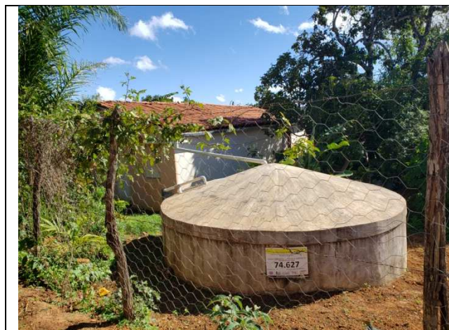
Foto 3: Cisterna de águas pluviais nas residências
