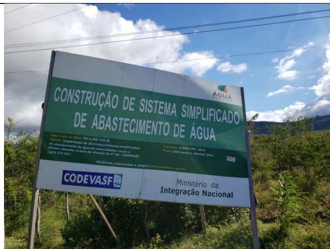
Foto 45. Placa da Codevasf no povoado do Catuabo.
