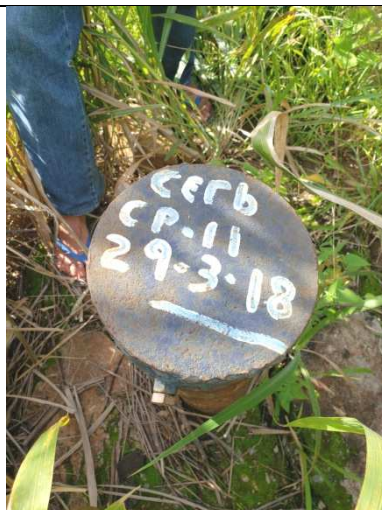
Foto 21. Poço tubular da Cerb perfurado na propriedade rural de José Alves da Silva (Pizé). Poço se encontra desativado. Segundo informação, houve curto circuito no painel de eletricidade e foi desativado. Esse é o ultimo poço antes da Cachoeira da serra.
