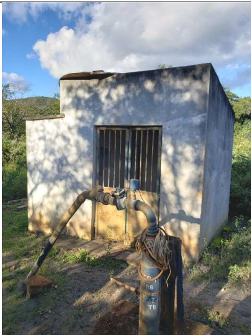
Foto 11: Poço da Cerb localizado na serra do Morgado. Atende ao Sistema de abastecimento de Juacema e adjacências. Água vai pra caixa de 100 mil litros para ser distribuída.
