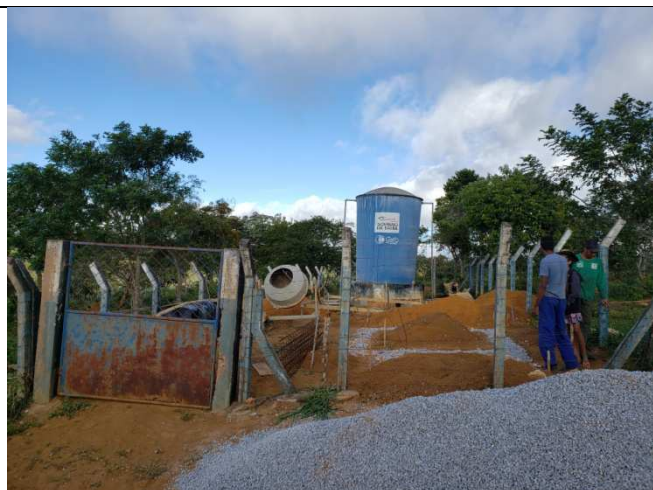
Foto 44. Reforma e ampliação do SAA dos Morgados
