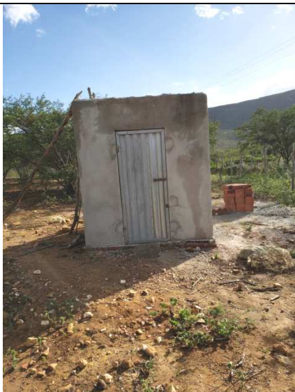
Foto 24. Poço tubular perfurado pela Cerb localizado dentro de um depósito. Poço perfurado próximo a BR 407
