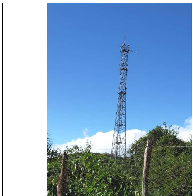
Foto 5: Antena de telecomunicações
