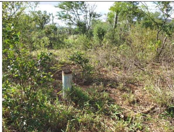
Foto 23. Poço tubular da Cerb perfurado no distrito de Juacema. Desativado e sem tampa. Localizado á margem de uma estrada.
