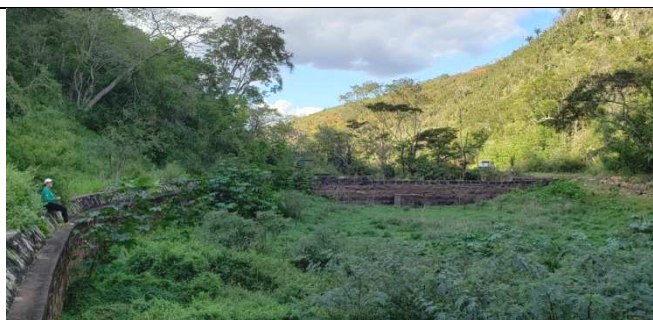
Foto 38. Vista geral da barragem do riacho da Cachoeira
