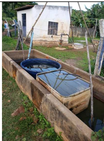
Foto 16: Poço da Cerb localizado na serra do Morgado. Atende ao Sistema de abastecimento do Morgado e adjacências com 120 ligações. Água vai pra caixa de 20 mil litros para ser distribuída. Bebedouro de animais.
