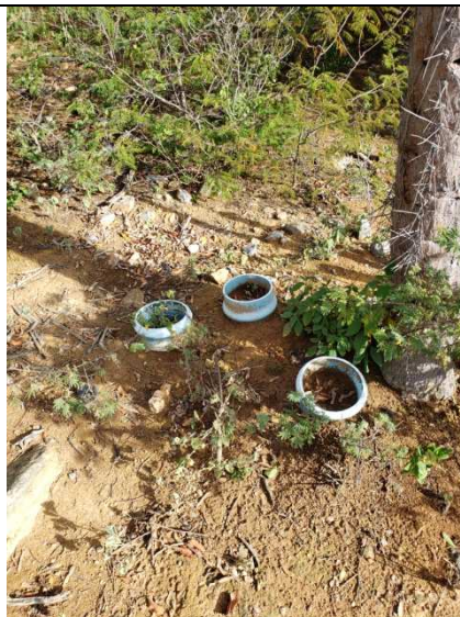
Foto 25. Material da perfuração do poço disposto sobre o solo.
