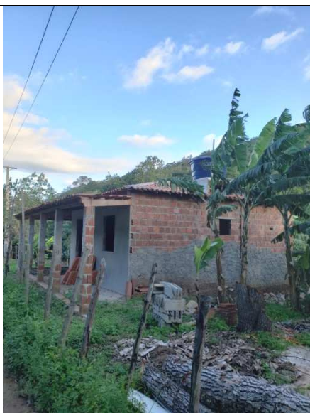
Foto 34: Residência rural nos Covões em construção.
