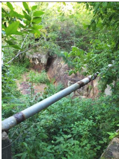
Foto 20. Tubulação de 5 polegadas descendo a serra a qual abastece o povoado de Juacema e adjacências por gravidade através da caixa de 100 mil litros localizada na serra do Morgado.
