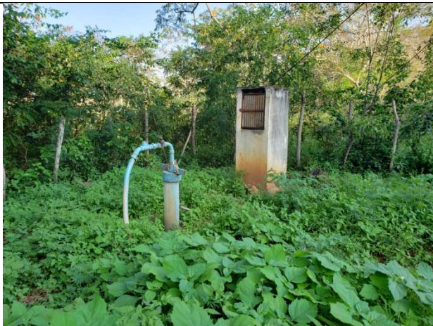
Foto 38: poço tubular instalado.
