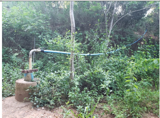
Foto 39: Poço tubular instalado. Imóvel rural de Franco Melo que mora em Jaguarari.
