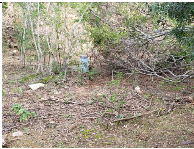
Foto 27. Poço tubular da CERB perfurado na estrada da Cachoeira. Encontra-se desativado e com tampa.
